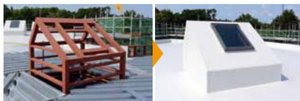
▲トップライトまわりにも断熱材を敷設しシート防水で施工した
