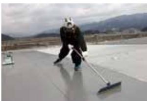
▲大屋根は接着工法で施工
