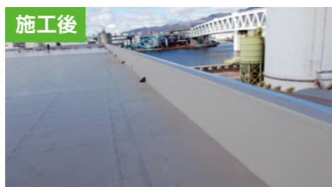
兵庫県 採用工法：110 仕様 既存防水：塩ビシート
