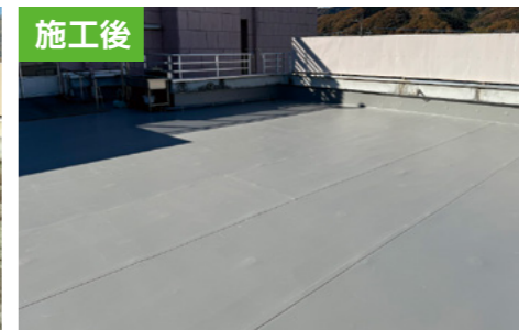
埼玉県 採用工法：210UD 仕様 既存防水：ゴムシート
