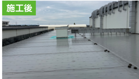
秋田県 採用工法：110 仕様 既存防水：塩ビシート
