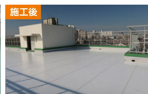
東京都 採用工法：210UD 仕様 既存防水：ウレタン塗膜
