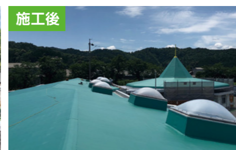
岐阜県 採用工法：210UD 仕様 既存防水：アスファルト
