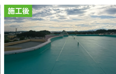
宮城県 採用工法：210UD 仕様 既存防水：塩ビシート
