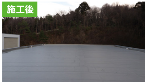
秋田県 採用工法：110 仕様 既存防水：ステンレス防水
