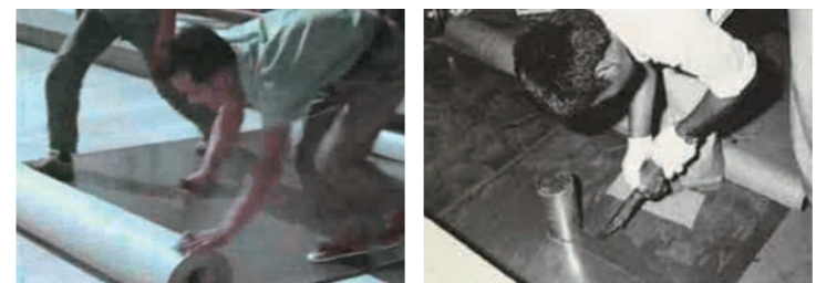
当時は接着工法のみで、ムーブメントに追従できる防水工法の模索が続いた。また、シートのジョイントは重ね継ぎ工法、帯溶接などいずれも溶接棒を使用し高い技量が求められた
