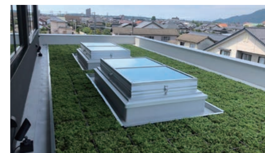
ロンググリーン「箱庭名人」施工事例
