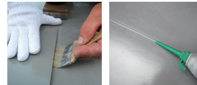
溶剤によるシートジョイント溶着処理
