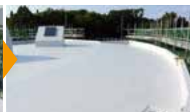
▲防水施工完了
