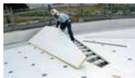
▲断熱材の敷設
