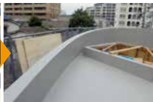
▲防水施工完了
