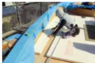
▲木質下地に断熱材を敷設
