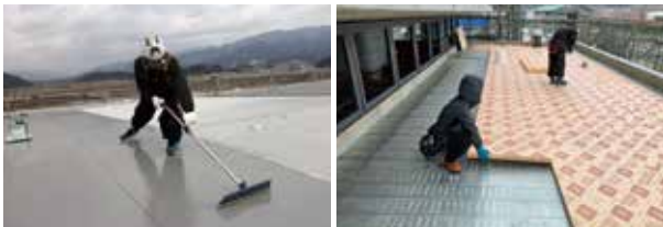
▲大屋根は接着工法で施工
