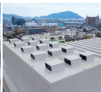
▲換気口まわりも「かぶせ工法」で改修
