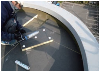
▲断熱材に接着剤を塗布
