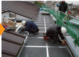
▲断熱材目地部テープ処理
