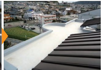
▲改修施工完了
