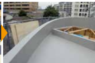
▲防水施工完了
