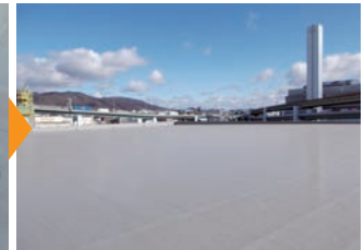
▲全面接着工法だから作業音も抑制でき、スムーズに改修施工を完了
