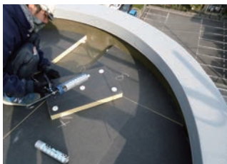
▲断熱材に接着剤を塗布
