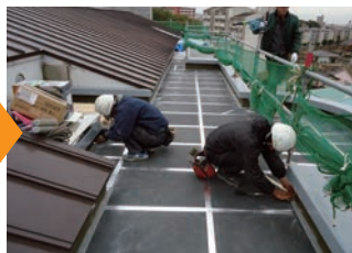
▲断熱材目地部テープ処理
