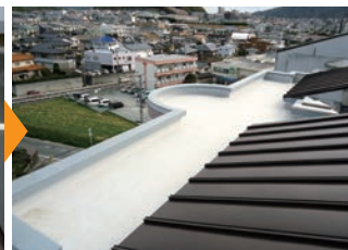
▲改修施工完了
