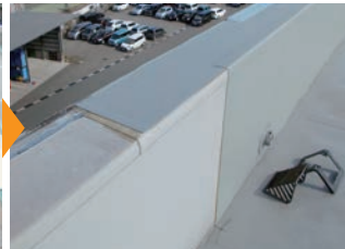
▲パラペットも既存シートの上に平滑に接着工法で施工した
